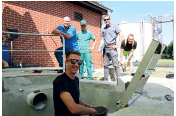
Baustellenbesichtigung auf der Kläranlage Drebkau, von links: Jörg Wille (LWG), René Dommning (LWG), Tino Schmidt (LWG), Kai Reschwamm (GFK-PRO) und vorn Niclas Sommer (GFK-PRO)
