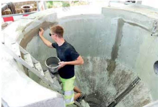
Bauarbeiten am Sandfang der Kläranlage Drebkau (Foto: LWG)
