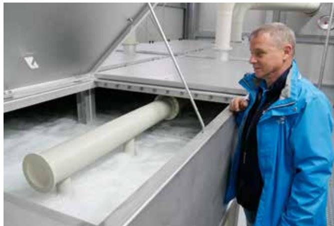
Bernd Scheppan, Gruppenleiter Wasserwerke der LWG, kontrolliert an einem geöffneten Flachbelüfter das Luftblasenbild.
