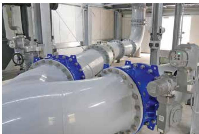
Durch diese Rohrleitungen und Armaturen mit 600 mm Innendurchmesser strömen stündlich bis zu 1,4 Millionen Liter Trinkwasser auf die beiden Flachbelüfter.
